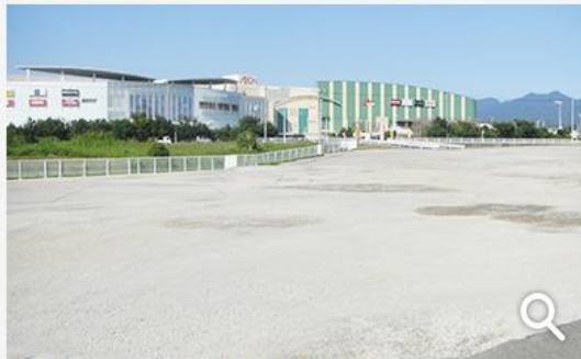
イオンモール高崎 駐車場造成工事
