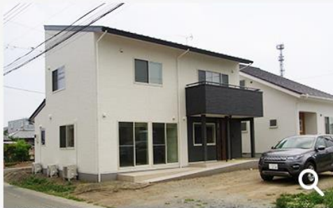
H邸新築工事
