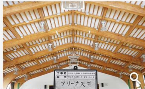
赤城北中学校体育館改修工事
